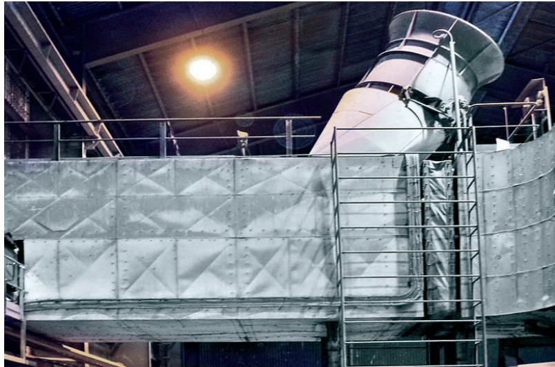
Защита трубопроводов для сырьевой муки от абразивного износа с использованием высокопрочного компаунда KALCRET, толщина футеровки 25-40 мм, температура применения 200 °C
