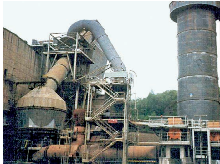
Надежная защита сырьевой мельницы и пневматических трубопроводов с помощью высокопрочного композита KALCRET BNХ
