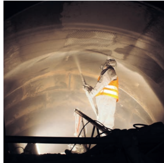
Защита трубопроводов для сырьевой муки от абразивного износа с использованием высокопрочного компаунда KALCRET, толщина футеровки 25-40 мм, температура применения 200 °C
