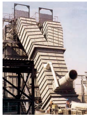
Футеровка трубопровода отработавших газов в охладителе с использованием высокопрочного компаунда KALCRET BNY
